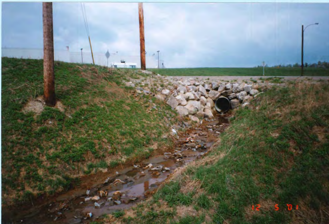
fossé en face du poste de garde
