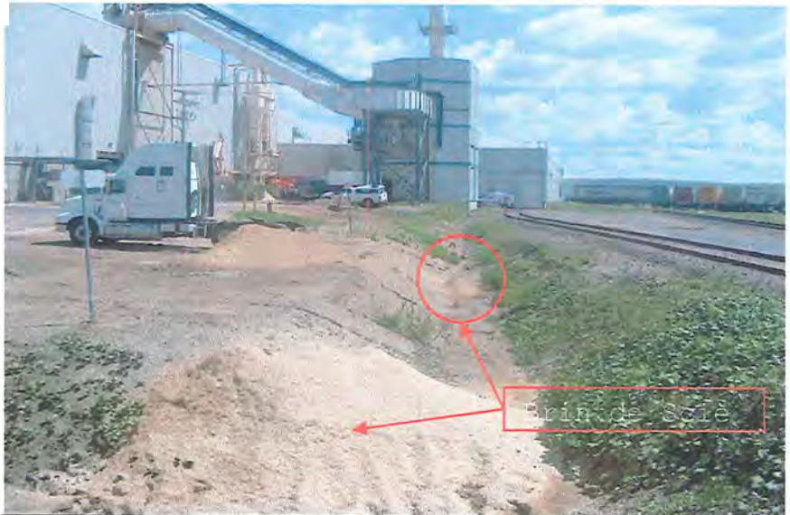
Photo 4 : prise par David Castonguay le 3 août 2005. Commentaires : illustre fossé de drainage dans lequel les boues liquide se sont écoulez et ont été confinée.
