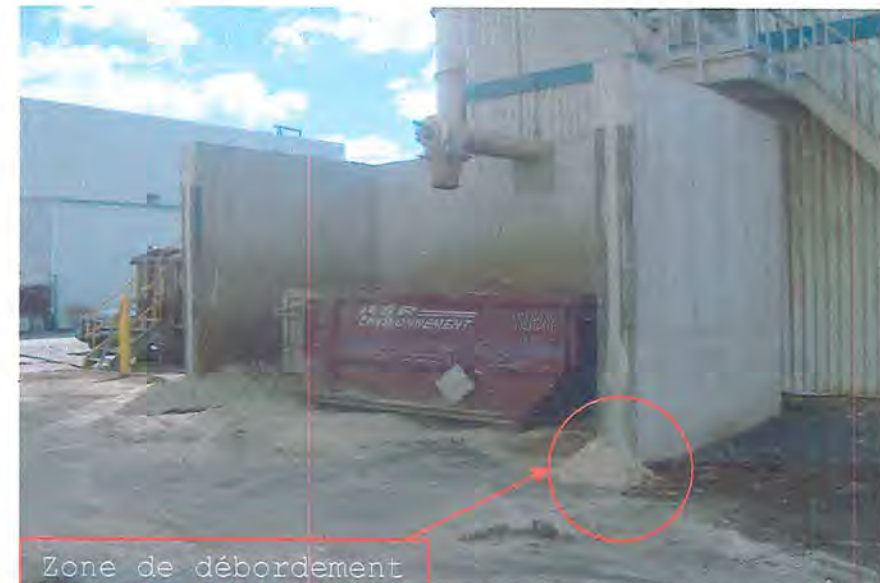
Photo 5 : prise par David Castonguay le 3 août 2005. Commentaires : Illustre le (fire dump) duquel les boues liquides se sont écoulez.
