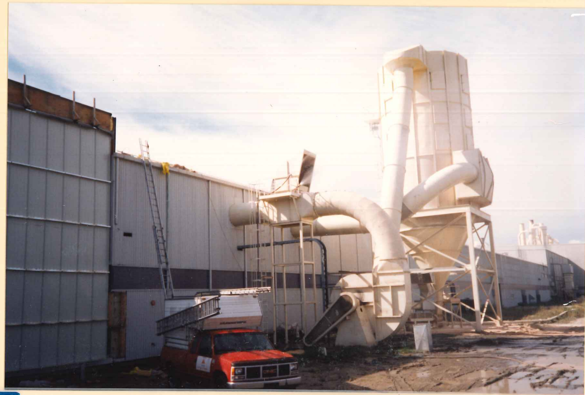
INSTALLATION D'UN ATOMISEUR DE FORTUNE (H)
